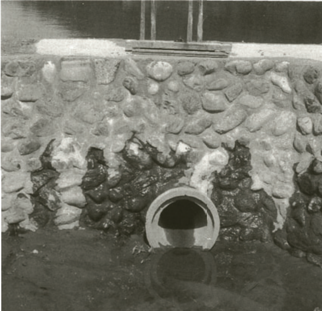
Σχήμα 4.19. Φωτογραφία του στομίου εξόδου του αγωγού αποχέτευσης νερού από τη δεξαμενή (Usui, 1991).
