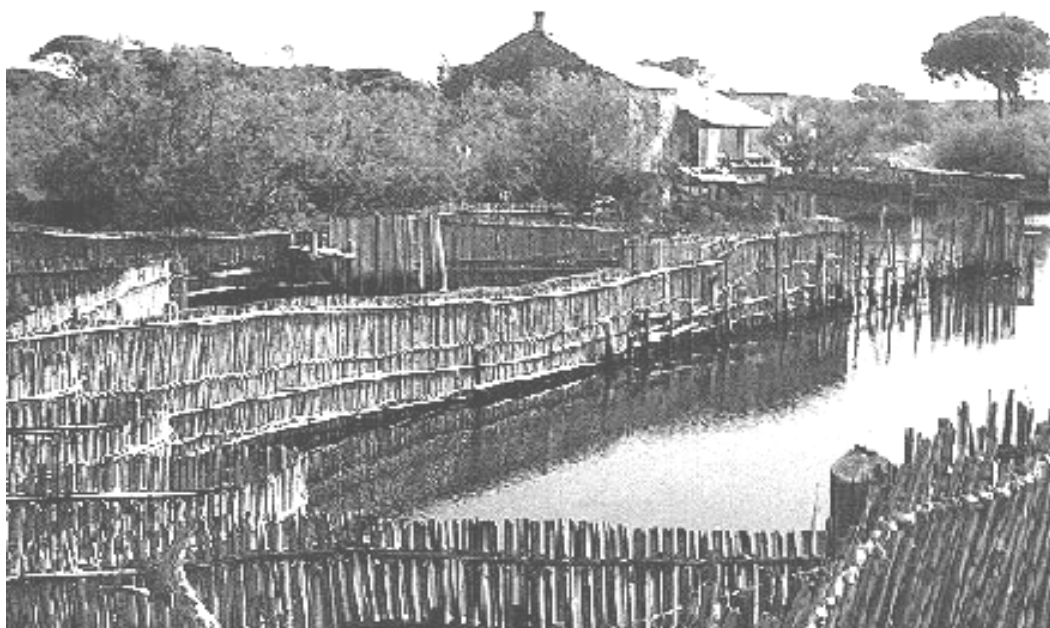
Σχήμα 1.10. Παραδοσιακές ιχθυοσυλληπτικές εγκαταστάσεις αποτελούμενες από φραγμούς φτιαγμένους από καλάμια στη λιμνοθάλασσα Πρόκοπος του Αράξου του νομού Αχαΐας.
