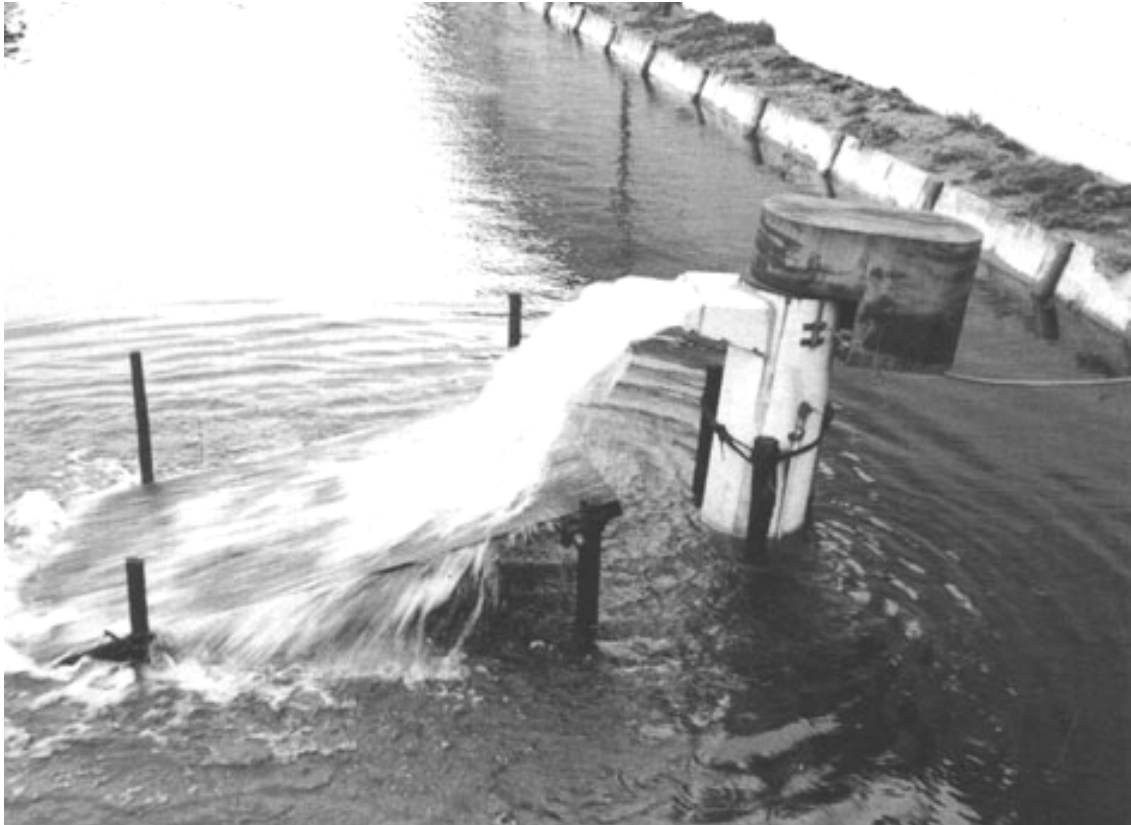
Σχήμα 4.11. Οξυγόνωση του νερού της δεξαμενής με τη χρήση υποβρύχιας αντλίας. Το νερό αναρροφάται από τον πυθμένα και διοχετεύεται στην επιφάνεια όπου πέφτοντας από κάποιο ύψος σε μία πλατιά επιφάνεια οξυγονώνεται επαρκώς (Usui, 1991).
