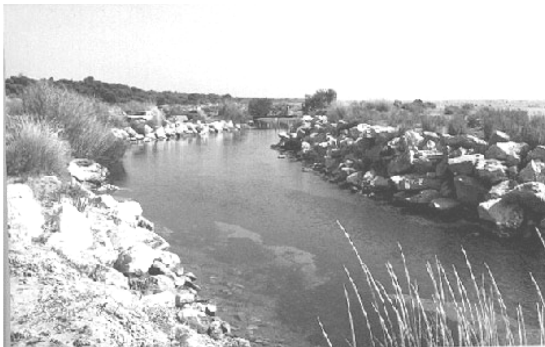
Σχήμα 1.16. Μέρος του διαύλου επικοινωνίας (μπούκα) της θάλασσας με τη λιμνοθάλασσα του Πρόκοπου (Αραξος Αχαΐας). Διακρίνεται δεξιά η ενίσχυση του πρानούς με μπετόν και λιθοριπή. Το συνολικό μήκος του διαύλου είναι περί τα 2 Km.
