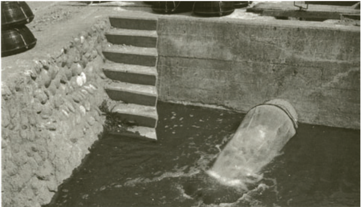
Σχήμα 4.20. Δίχτυ εφαρμοσμένο στο στόμιο εξόδου του νερού με σκοπό τη σύλληψη των χελιών στην περίπτωση που αφεθούν ανεμπόδιστα να παρασυρθούν με το νερό εξόδου (Usui, 1991).
