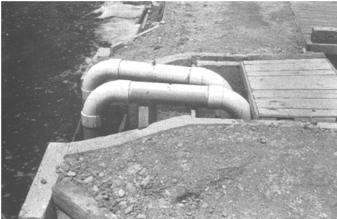
Σχήμα 4.18. Φωτογραφία διπλού σιφωνιού αποχέτευσης νερού δεξαμενής σύμφωνα με όσα αναφέρονται στο προηγούμενο σχήμα με μόνη διαφορά ότι η έναρξη λειτουργίας γίνεται με υποβρύχια αντλία (Usui, 1991).
