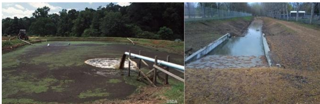
Σχήμα 40. Δεξαμενές εναπόθεσης των υγρών αποβλήτων μιας μονάδας ιχθυοκαλλιέργειας κλειστού συστήματος. Η συσσωρευμένη οργανική λάσπη «χωνεύεται» και μπορεί μετά από κατάλληλη επεξεργασία να μετατραπεί σε οργανικό λίπασμα για αγροκαλλιέργειες.
