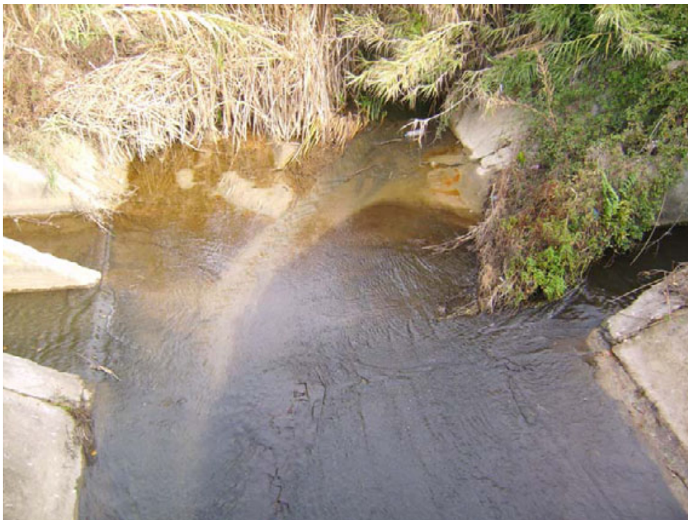
Εικόνα 2.2. Άποψη του σημείου όπου ενώνονται οι παροχετεύσεις των αρδευτικών καναλιών με την αύλακα (σταθμός Α).
